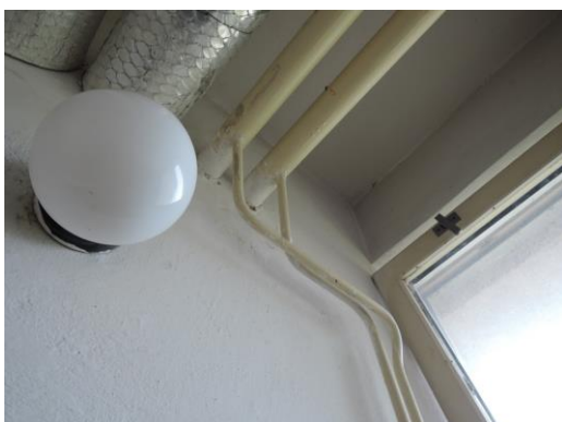
instalace vadí otevírání okna
